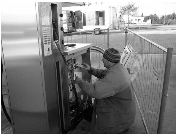
Er installierte fachmännisch die Anlagen für die Erdgas- und Autogas-Tankstelle in Bargeshagen, der -Servicemonteur Torsten Hesse (39) aus der Firma Erdgasfahrzeuge München.
