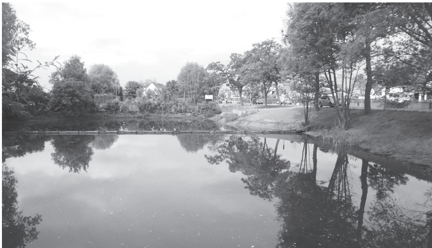
Der sanierte Löschteich
