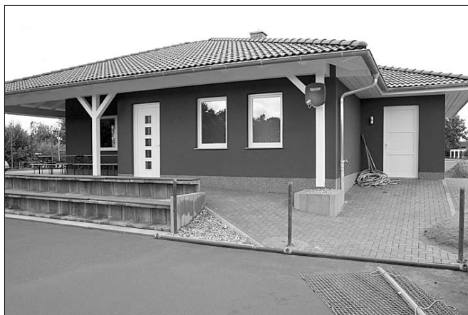
Ein Schmuckstück, das neue Vereinsgebäude des TCB.
