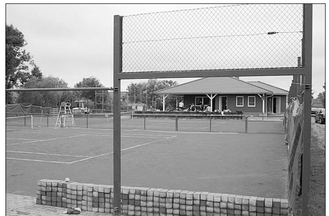
Der Platz ist bereit für den Probebetrieb.
