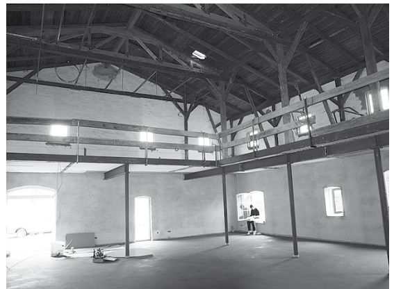
Der zukünftige Saal mit Galerie
