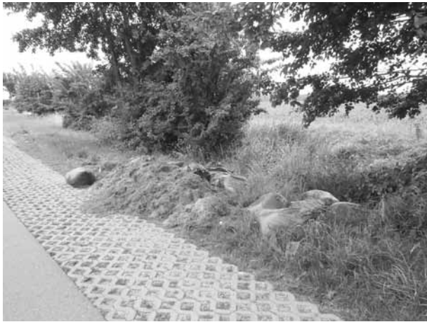
Rasenentsorgung an der Straße zwischen Rabenhorst und Rethwisch – so kann es doch auch nicht sein!
