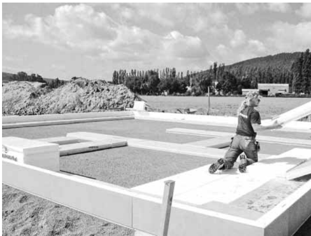
Auf den vorbereiteten Untergrund werden die Dämmstoffplatten verlegt
