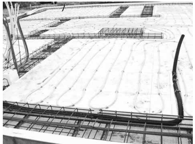
Die Stahlbewehrung, die Versorgungsleitungen sowie die Fußbodenheizung verlegt
