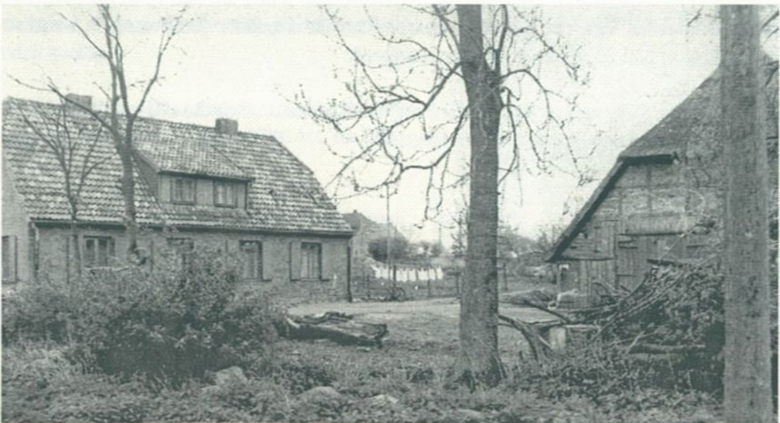
Arbeiterwohnungen, Scheune Hof Krempien
