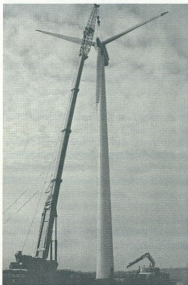
Errichtung einer Windkraftanlage
