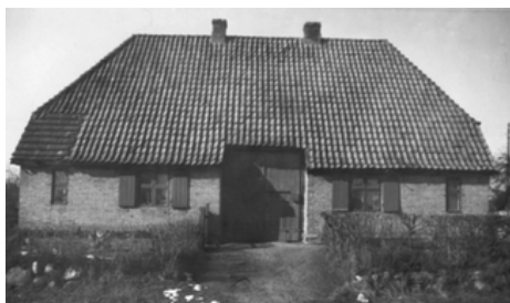
Nr. 3, Hof Goesch, Katen , heute: Hauptstr. 7 abgerissen
