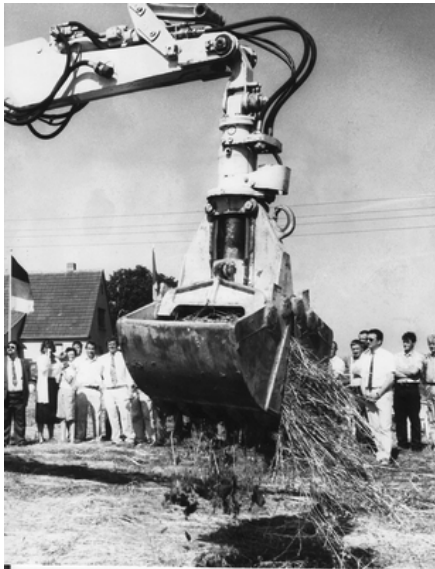
Den symbolischen ersten Spatenstich nahm mit einem Bagger der damalige Bürgermeister Klaus-Peter Wiendieck vor
