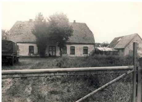
Nr. 7, Hof Barten, heute: abgerissen, Admannshäger Damm
