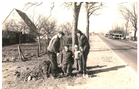
Bau der Straßenbeleuchtung 1974
